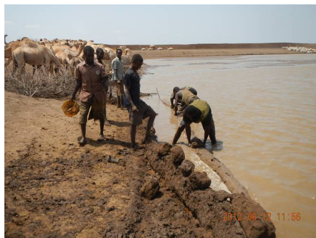
Galgalu平原の既存Water Pan（Turbi市近郊） 家畜水飲み場兼堆砂除去作業の様子：堆砂除去作業は効率が悪く継続的なO&M作業の為に施設改善が求められる
