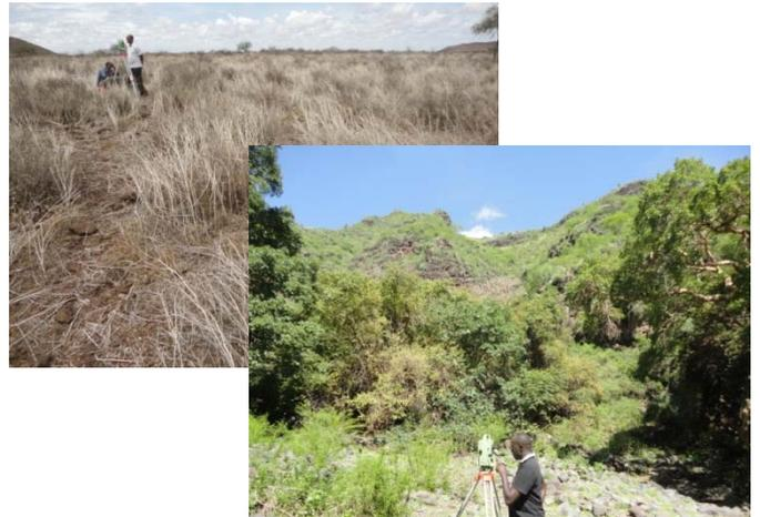
測量作業: Water Pan予定地 建設予定地において測量作業を行いました。 GPSを利用しながら位置を確認し、標高データを測量によって取得します。(左上: マルビ ット郡中央郡Gar-Qarsaのwater pan予定地 / 右下: 南郡ArapalのPipeline予定地)
