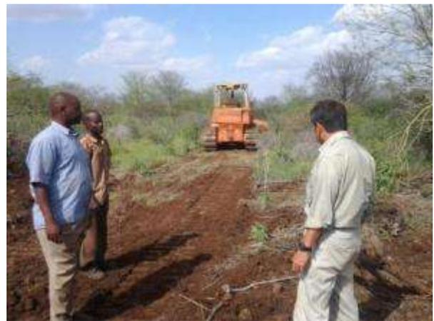
Dololo Dukatu 溜池への仮設アクセス道路 (ルガ` ット中央郡) : 家畜用溜池は牧草地帯の中に設置する必要があります。この溜池も近隣村から約20km離れた地点に位置し、当初は徒歩でのアクセス(往復2日)しか出来ない状態でした(写真左上)。よって、まずは住民の協力を得てオートバイが通行できる状態にまで拡張し(写真左下)、予備調査を実施。再委託業務入札業者への現地説明会の際もオートバイで現地へ行きました。今月、当該工事の業者との再委託契約を締結(12/24)し、早速業者は工事現場へのアクセス道路工事を着工。3日間で約10km区間の工事を終えました。完成すれば村から約2.5時間(by車)のアクセスに短縮されます。
