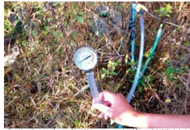
短期専門家の指導による水道公社機材を用いての水圧テストの実施
