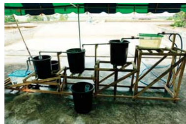
チャンポン浄水場に設置されたEPSモデル実物
