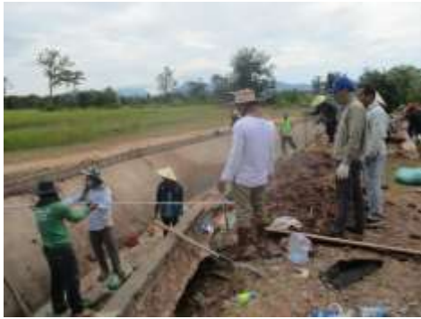
写真：現況調査
