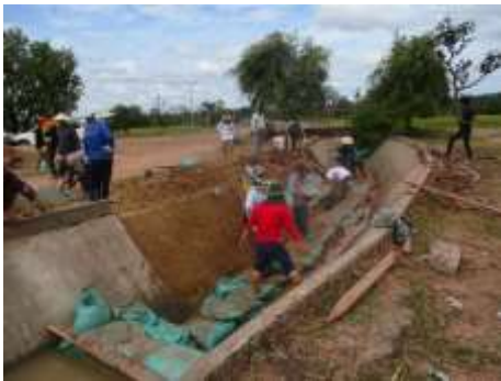
写真：補修作業
