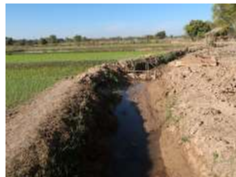
写真：土水路（幹線）
