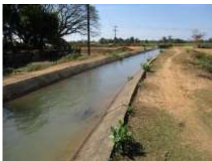
写真:幹線水路(取水地点)
