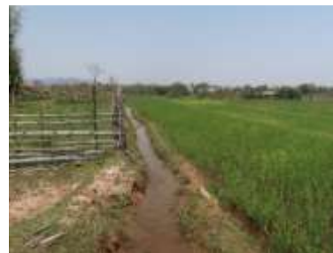
写真：掘削延長した2次水路
