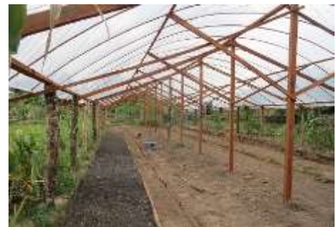
写真：屋根掛け設置状況
