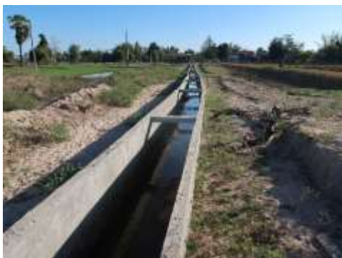
写真：コンクリート水路（幹線）
