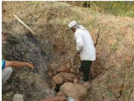
写真:断面成形
