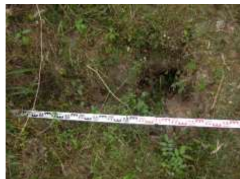
写真：底面にできた小崩落個所
