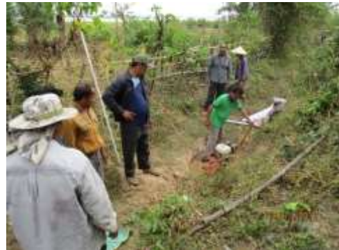
写真:埋め戻し土転圧
