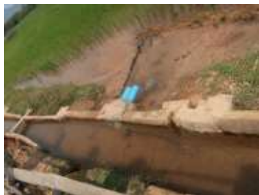
写真：2次水路取水口（改修後）
