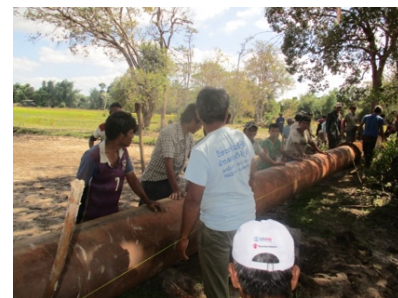
農家全員でパイプを設置中 (詳細は次号でお知らせ)
