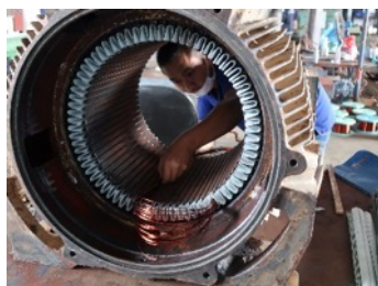
コイル取り付け(重要な作業)
