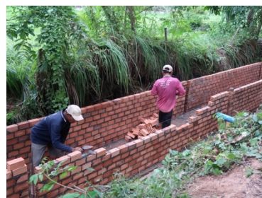
自力で水路を整備中
