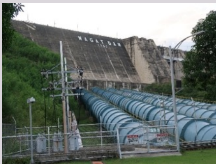
灌漑・発電用ダム(売電収入は灌漑予算として使用) ＜フィリピン＞
