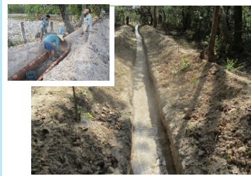
新たな水路掘削
