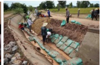
補修技術研修(実地)
