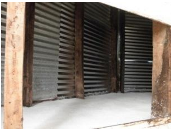
GF の屋根(まだ細かい穴が残っている)
