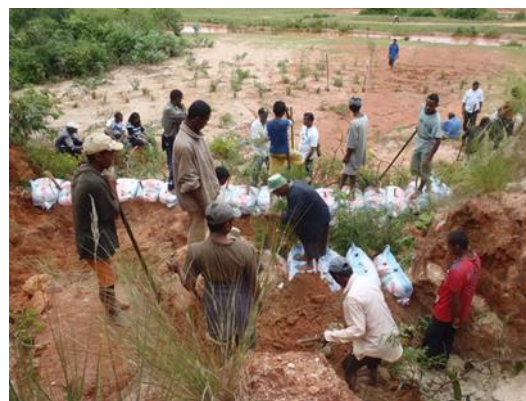
Actions de lutte contre les lavakas par les populations à leur propre initiative avec des matériaux disponibles localement.
