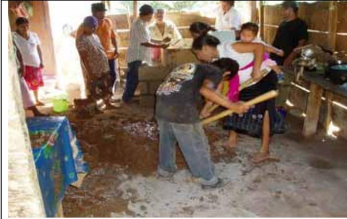
Trabajo colectivo en la Preparación de la Mezcla, que será utilizado para la construcción del Fogón Ecológico.
