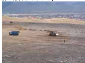
処分場の覆土状況
