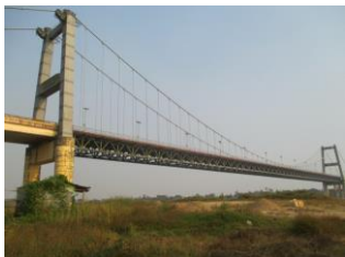
損傷したつり橋
