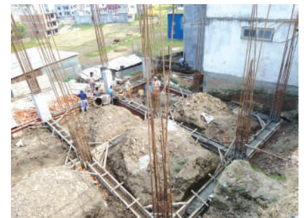
बनिरहेको निर्माण स्थल
