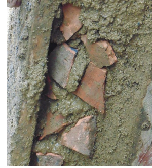
Relleno de deformidades con tejas quebradas
