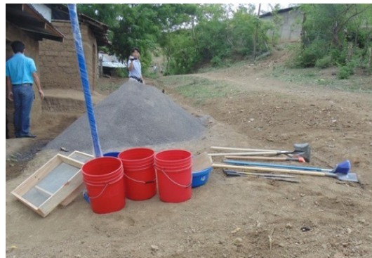
Zaranda pequeña de malla fina de (1/16"). (Izquierda) para colar la arena y otras herramientas.
