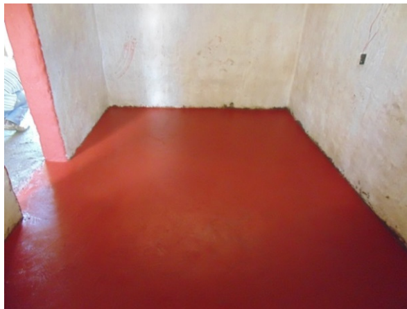
Colocación de la capa final con colorante
