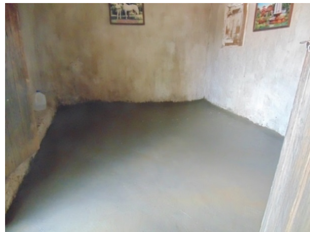
Colocación de la capa media
