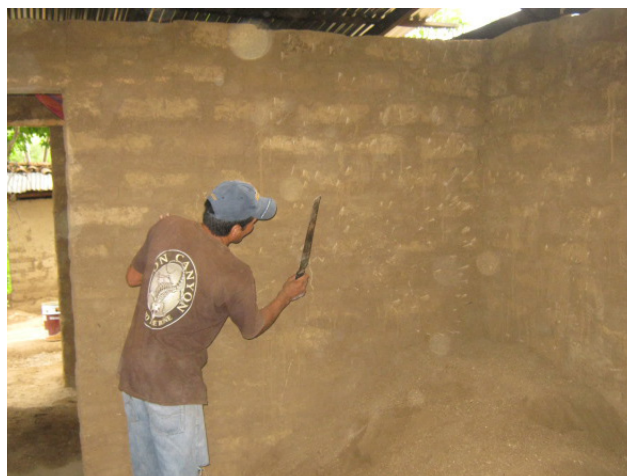
Picar la pared para mejor adherencia del material
