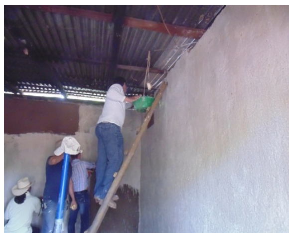
Pintando las paredes con la cal y sal.
