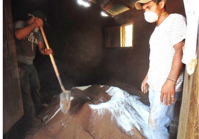
Mezcla de tierra, material selecto y cal.
