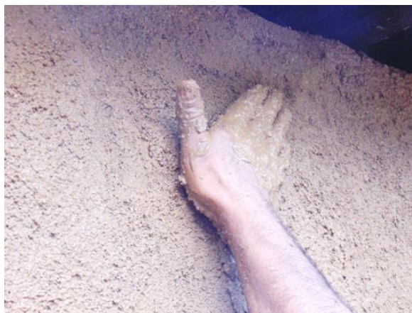
Alisando la pared con la mano mojada después de aplicar la mezcla.
