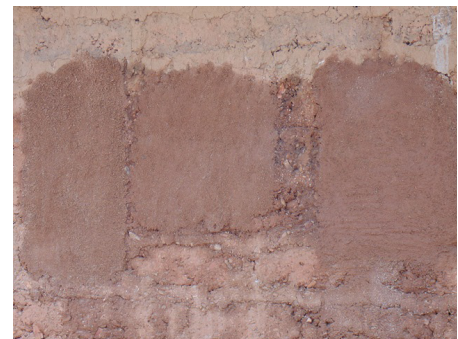
Tres cuadros de mezcla en la pared. De izquierda a derecha; 3x1, 2x1, 1x1 (arena x tierra).
