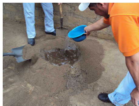
Mezcla de tierra y arena para la pared.
