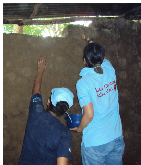
Aplicando la mezcla con la mano
