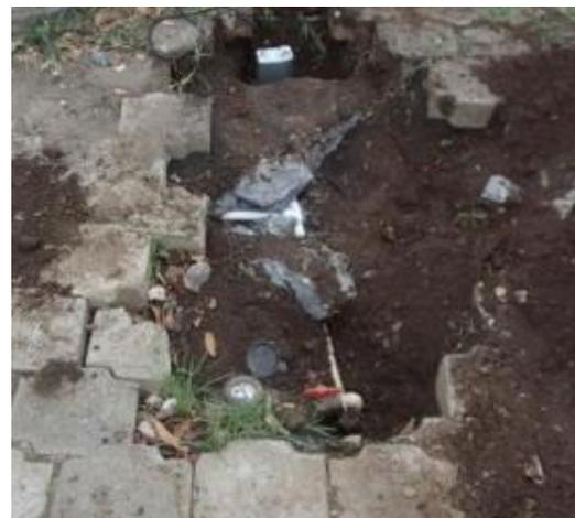
写真 盗水の状況(バイパス管非合法接続)
