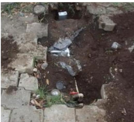
Foto: Robo de agua (Conexión Ilegal de con tubería de By-Pass)
