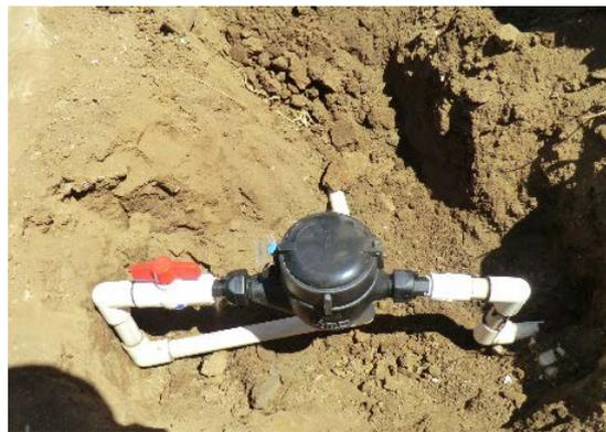
写真2 水道メータと曲管の設置
