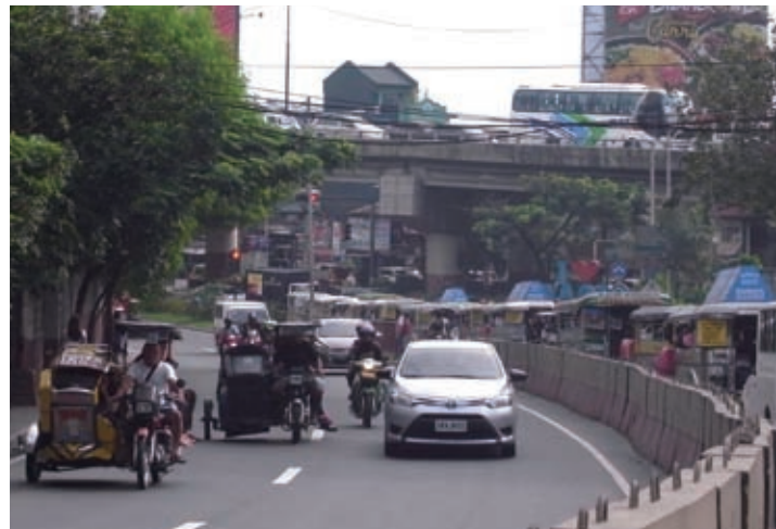
円借款で建設された首都圏バング市内の環状道路立体交差
