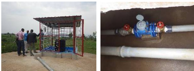
写真 3 パイロット工事で設置された塩素注入装置(左)と、水道メータ(右)
