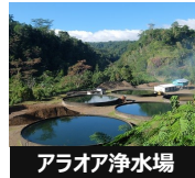
アラオア浄水場
