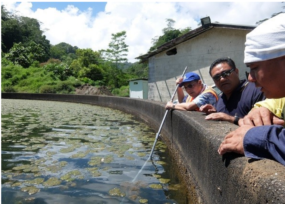
「EPSの視点・考え方は日本発の発想の概念と技術です。『自然の仕組みの賢い活用』、これこそが日本が世界に誇れる国際貢献のカチです」 砂ろ過池内の生物浄化機能を確認する中本専門家 (左)
