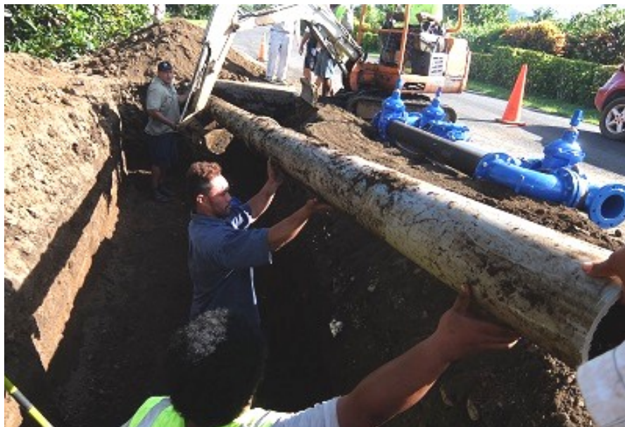
動き出した流量計室建設。ファガリイ地区（DMA 2）建設予定地にてバイパス管設置作業を行うカウンタパート職員3名はいずれも沖縄研修の経験者
