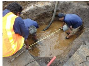
メジャーを用い、必要な管の長さを確認(漏水管取換え作業)
