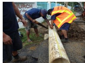
“大体”の長さではなく、適切な長さを測り、切り損じを減らす
