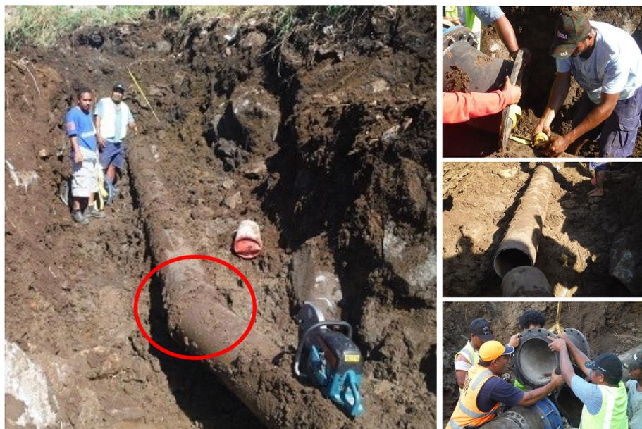
急斜面を走るダクタイル鉄管（400mm）の接合部分からの漏水。敷設時に管を守るためのコンクリート防護がされていないため、裸一つで耐えてきた管がついに悲鳴を上げたのだ
