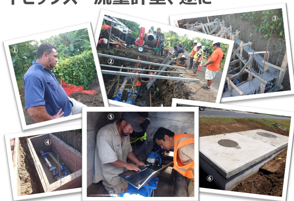
①現場監督担当の工務課 ウィリアム職員 ②ベースへのセメント流し込み ③側壁の型枠・鉄筋組み ④型枠外し ⑤ロガーをセッティングする無収水班ウルファア(左)とマシュー(右) ⑥レラタ流量計室
