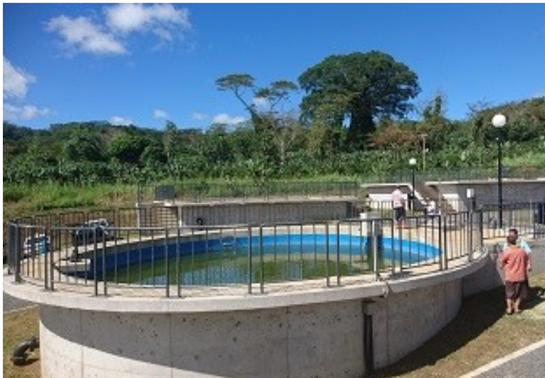
完成したタバタバオ浄水場。ろ過池は、アラオア浄水場と同じ“円形型”が採用されています。写真①沈殿池 ②粗ろ過池 ③砂ろ過池
