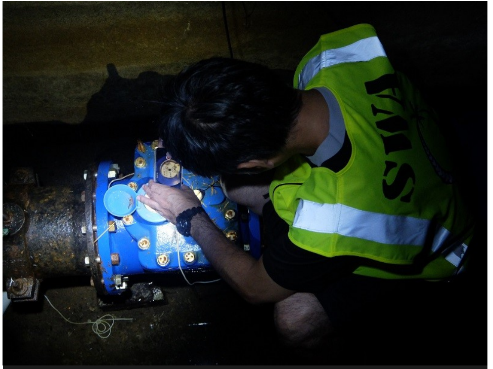
「水圧問題がほぼ解消され、今後はDMA単位の無収水量や夜間最小流量の分析力の向上、分析結果に基づいた漏水調査計画の策定・実施が重要になってきます」夜間調査で流量計の動きを確認する仲宗根さん
