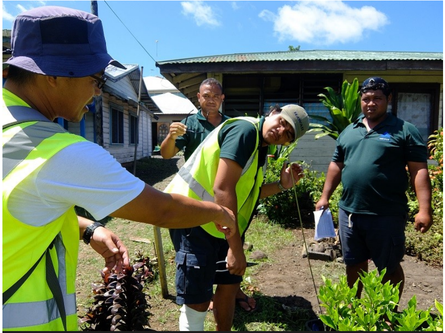
「漏水調査には一連の作業手順がありますが、その一つ一つの必要性を実感しなければ、調査活動は継続していきません」音聴棒から聞こえる漏水音をスタッフに感じ取らせる具志堅さん(左)
