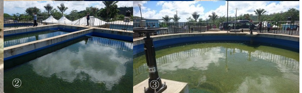
完成したタバタバオ浄水場。ろ過池は、アラオア浄水場と同じ“円形型”が採用されています。写真①沈殿池 ②粗ろ過池 ③砂ろ過池
