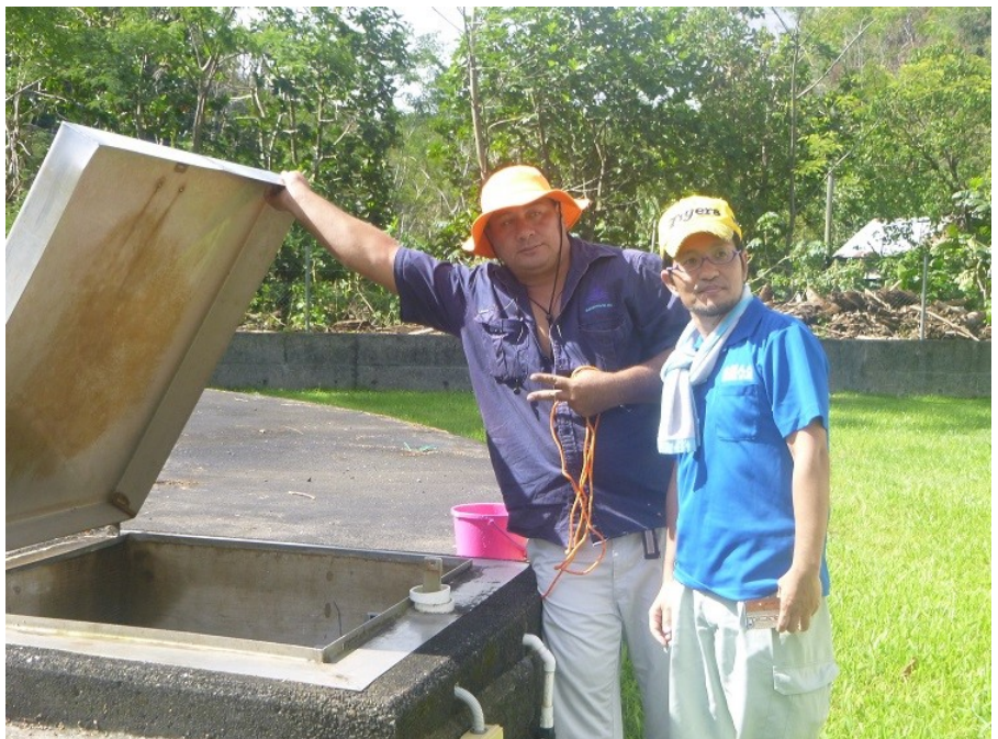
「アラオア浄水場では塩素管理を徹底しましょう。浄水場施設の規模から高濁度の除去は困難な場合もありますが、塩素管理ができていれば大丈夫。大腸菌の発生は防げます」と、伊佐専門家
