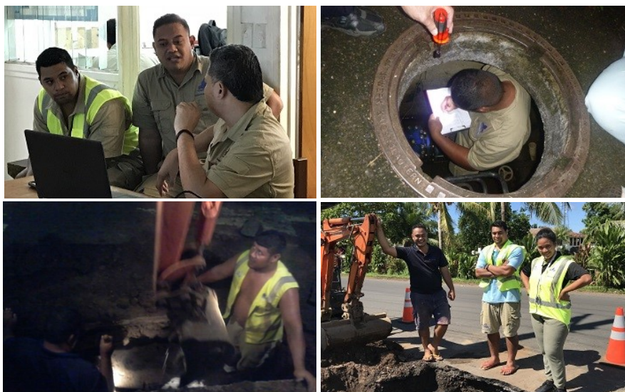
地道な漏水調査とその修理作業。漏水の多い配水管を割り出し、布設計画につなげます
