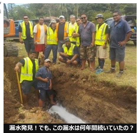
無収水・漏水班へのロギング研修の様子
