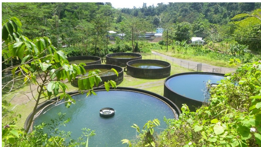
前2基は沈殿池、後ろ4基がろ過池。5基の砂ろ過池には規模が小さいが、効果的な管理に挑みます
