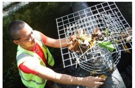
むき出しの取水管口にネットを製作。日々清掃を！
