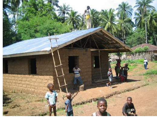
2008年7月19日、屋根が完成。
