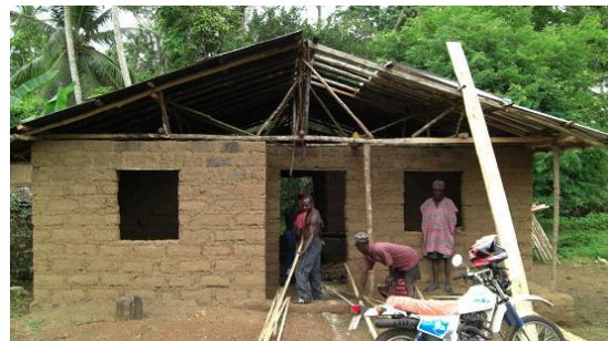
コミュニティの人たちで屋根の設置作業。
