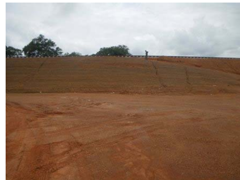
フィーダー道路を分断する巨大盛土。人が小さく見え
