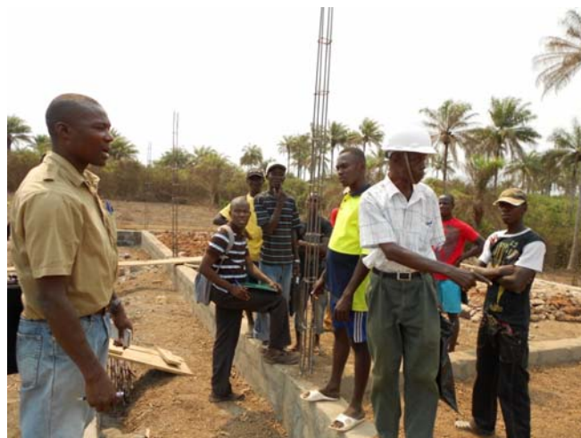
地方行政関係者が指導するコミュニティインフラ整備工事。
