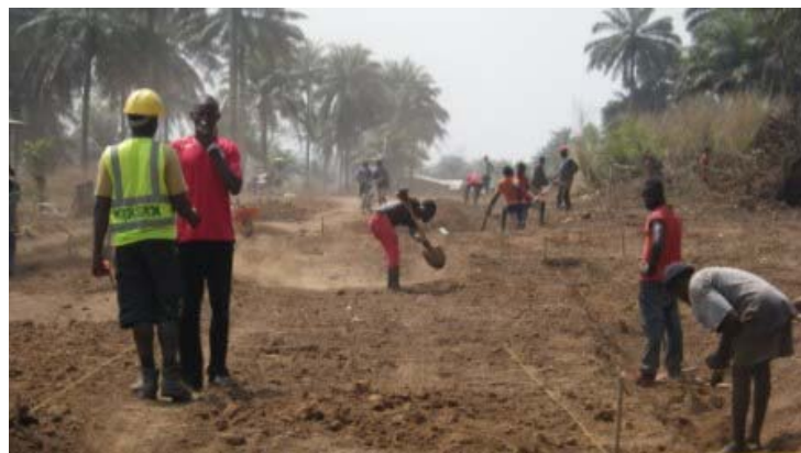
フィーダー道路改修工事の現場。
