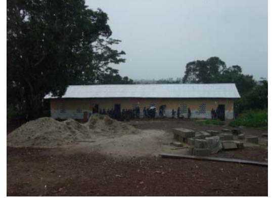
小学校建設現場
