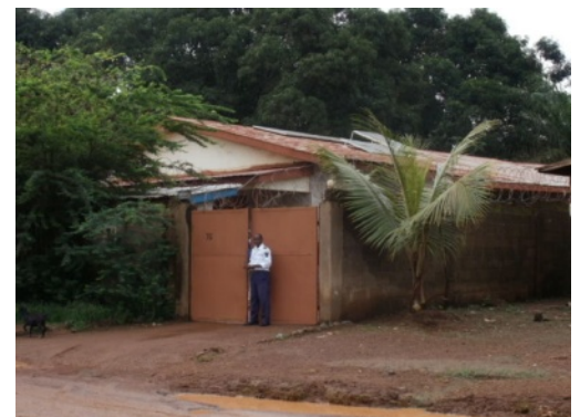
プロジェクト宿舎。屋根にはソーラーパネルを設置。
