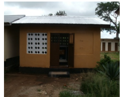
プロジェクト事務所用の発電機小屋。
