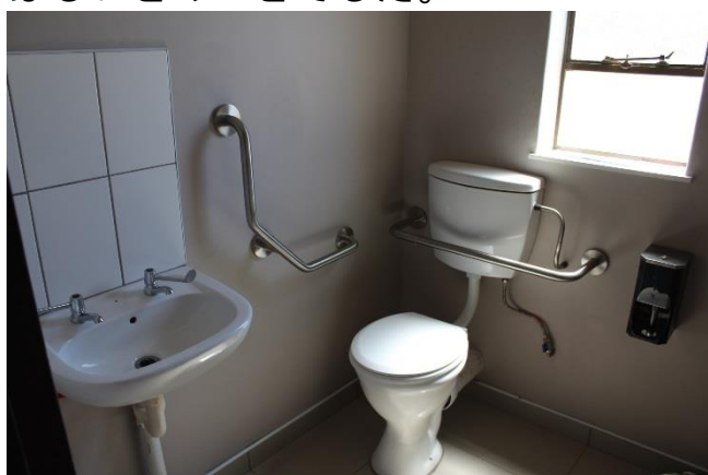
(写真) コミュニティホールに設置されたバリアフリートイレ
