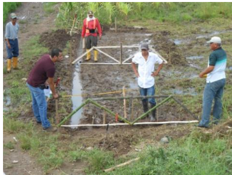
Armado y ubicación de plantillas
