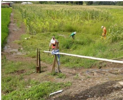
Limpieza y desbroce
