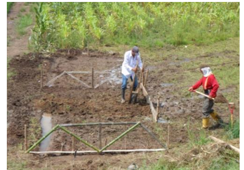
Compactación del muro
