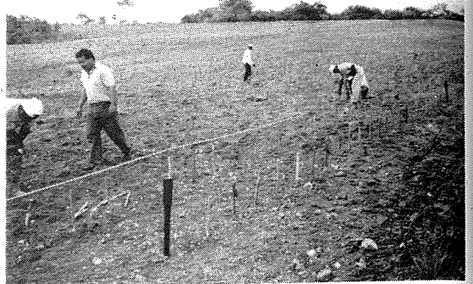
Figura 3-21. Trazado con cuerda graduada
