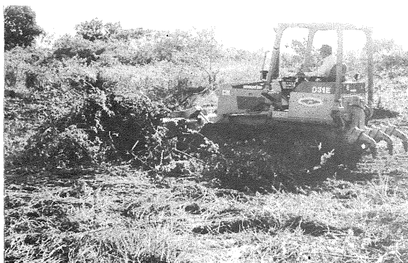
Figura 3-15. Forma mecánica de preparación del sitio o área que consiste en el desmonte de la Vegetación Leñosa con un tractor de oruga.
