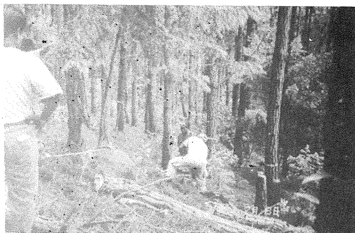
Figura 5-23. El proceso de apeo de árboles en pendiente debe realizarse con cuidado y conservando el distanciamiento para evitar la pérdida de suelo por erosión
