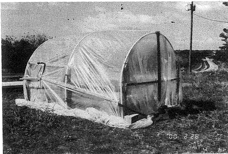
Figura 6-28: Construcción de invernadero Secador, 3x3x2 metros.
