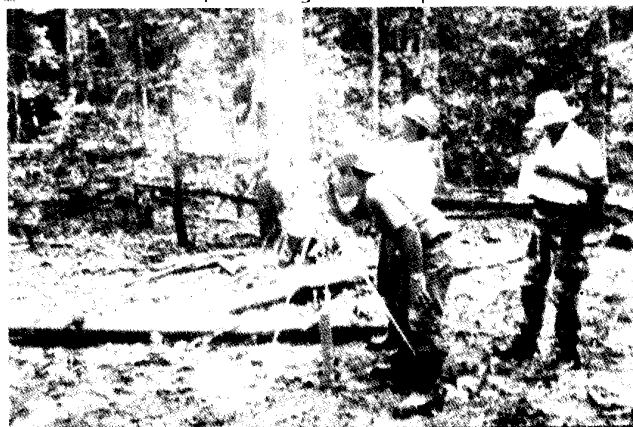
Figura 4-2 y 4-3. Uso del Compás de Agrimensor para delimitación de parcelas.
