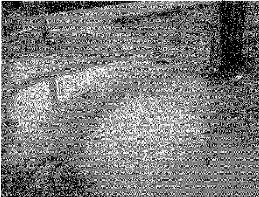
Media luna construida donde termina las curvas de nivel, Parcela Demostrativa, J-Green
