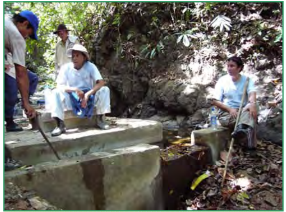
Protección de toma de agua en Peñas Blancas, Parque Nacional Chagres
