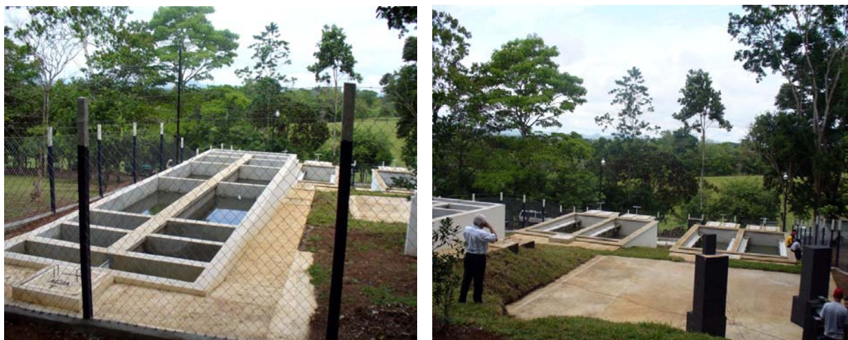
Foto 30 y 31. Acueducto de Cerro Cama.
