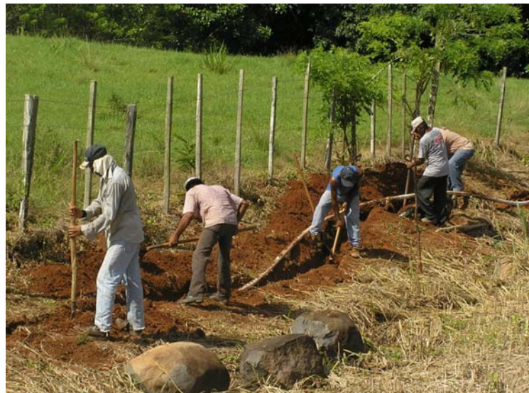
Foto 29. Grupo de beneficiarios instalando tuberías del acueducto de La Colorada.
