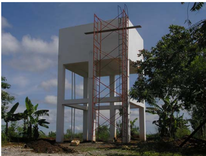
Foto 28. Nuevo tanque de almacenamiento de 10,000 galones, La Colorada
