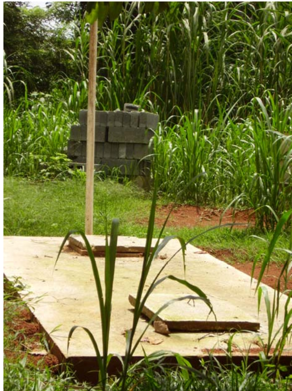
Foto 17. Fosa construida con respiradero para el manejo adecuado de la mortalidad en fincas avícolas.
