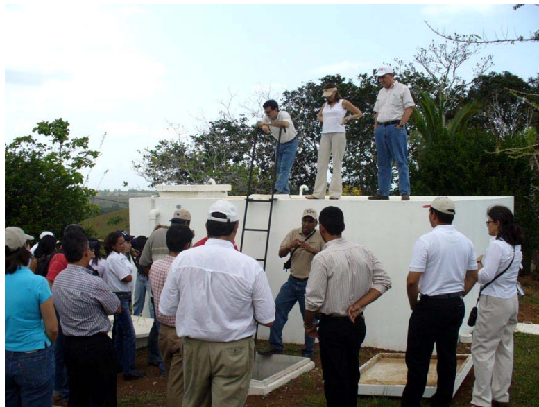
Fotos 27. Tanque de agua de la comunidad de Mendoza.
