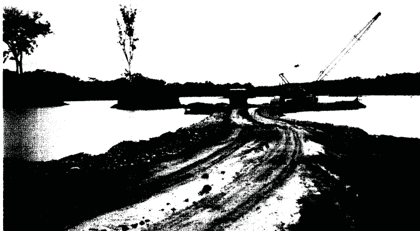
Extracción de grava y arena en el río Chagres.
