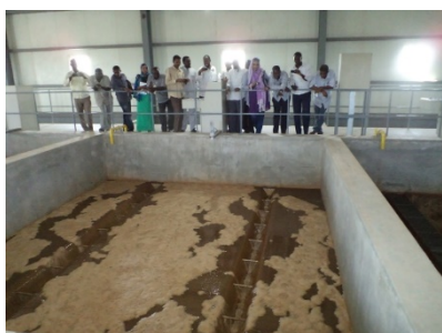
シンジャ浄水場急速ろ過池逆流洗実演状況(1/4)
