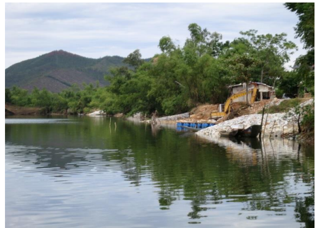
クアンビン省における水制工による河岸侵食対策工事
