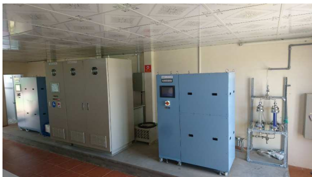
↑ 両端の青のがSOFCシステム。
