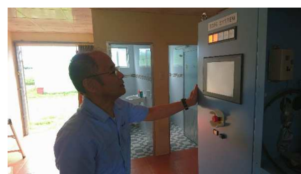
↑ 据付作業を終え、機材の確認を行う様子。
