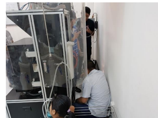
↑SOFC関連機材の調整を行う安倍さんとINTスタッフ。
