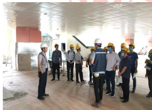
建設中の駅でコントラクターから説明を聞く第 4 期生
